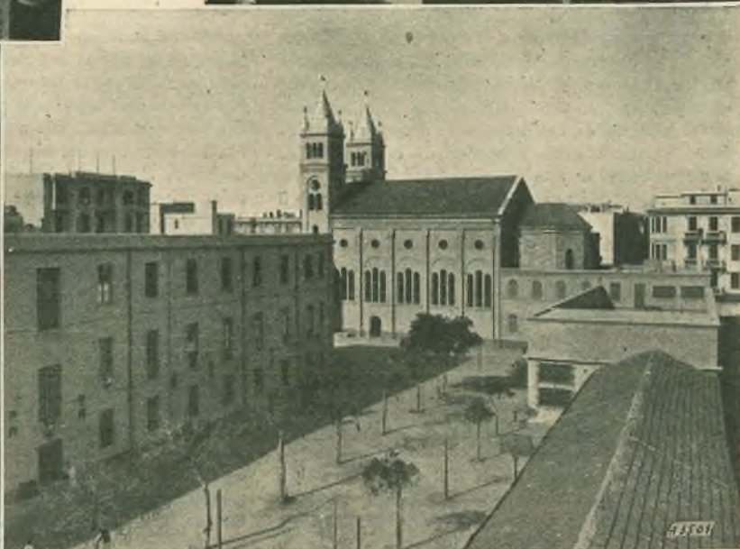
La chiesa, le scuole elementari e medie e i refettori visti dal cortile.
